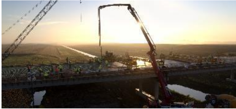
County Road - Deck Pour
